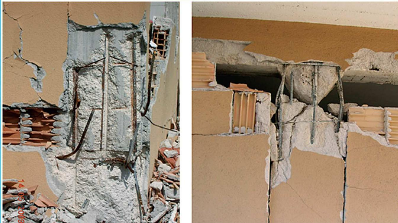
Figura 10.35. Terremoto de L'Aquila del 06/04/2009: materiali scadenti
