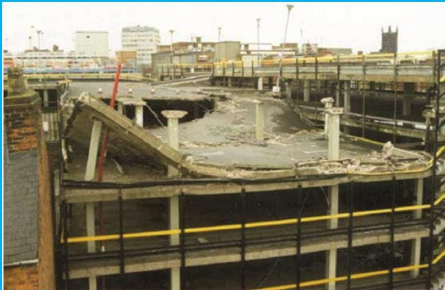
Rottura per punzonamento verificatasi in USA
